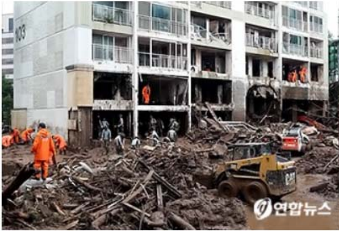
[사진] 우면산 산사태로 인하여 우면산 건너편 아파트에 쌓인 토사 잔해
